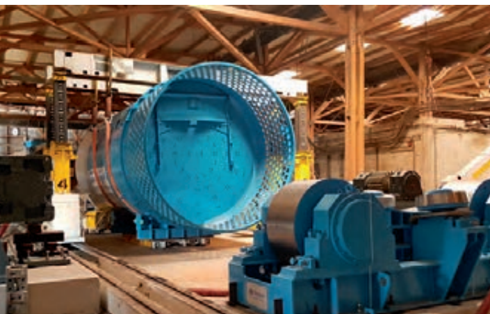
Avril - Travaux du centre de valorisation d'Étoile sur Rhône
